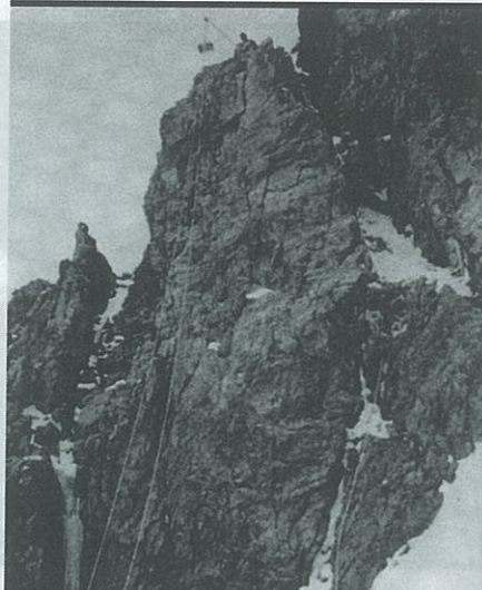
یک کابل مجهز به ونج برای بالا بردن تجهیزات به ارتفاعات در سال ۱۹۳۹ به ابتکار بیل هاونس مورد استفاده قرار گرفت.
